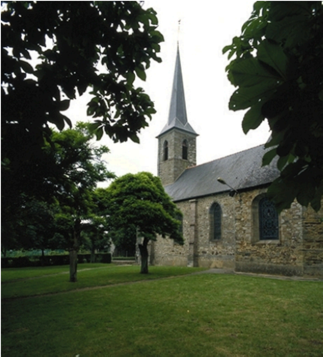
Le clocher : vue générale sud-est
