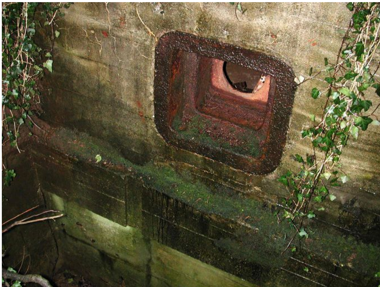
Vue de l'embrasure à rotule du canon. Au premier plan, la fosse à douille
