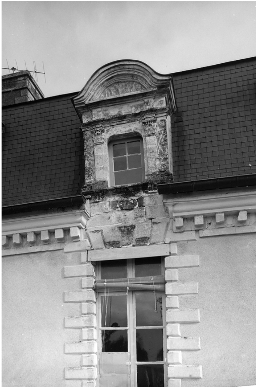
Face ouest, détail de la lucarne centrale.
