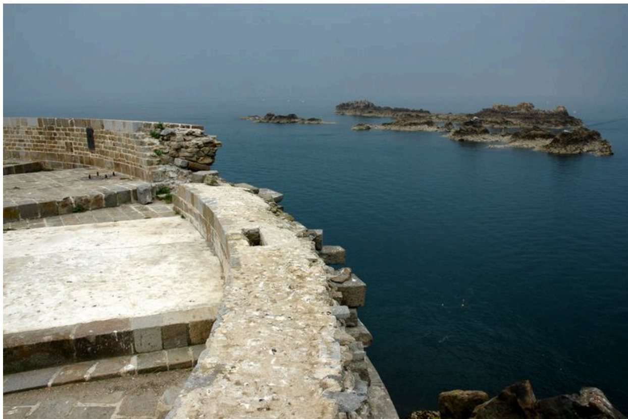
Vue du fort de la Conchée : plate-forme d'artillerie (batterie haute). En arrière plan : les haies de la Conchée
