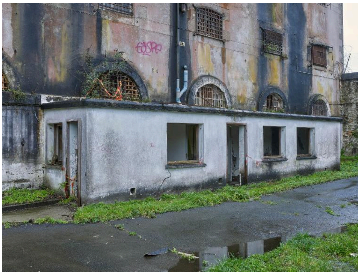
Vue du bâtiment accolé à l'élévation est
