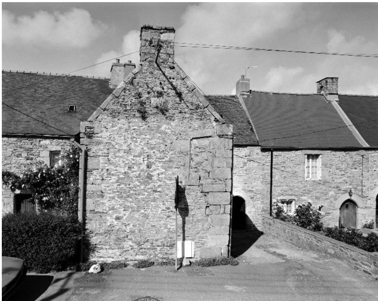
81-83 rue Albert de Mun, élévation ouest, vue générale
