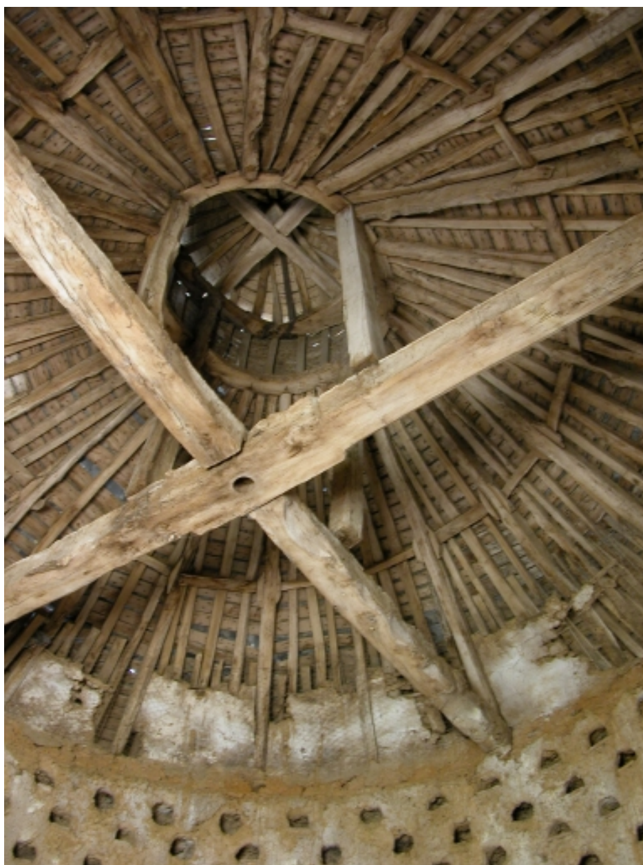
Pigeonnier ; détail, charpente
