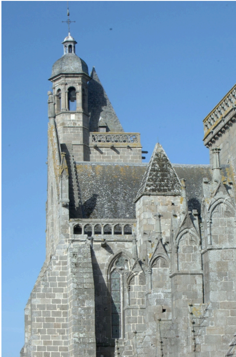
Pinacles côté sud du choeur, bras sud et sommet de la tour sud
