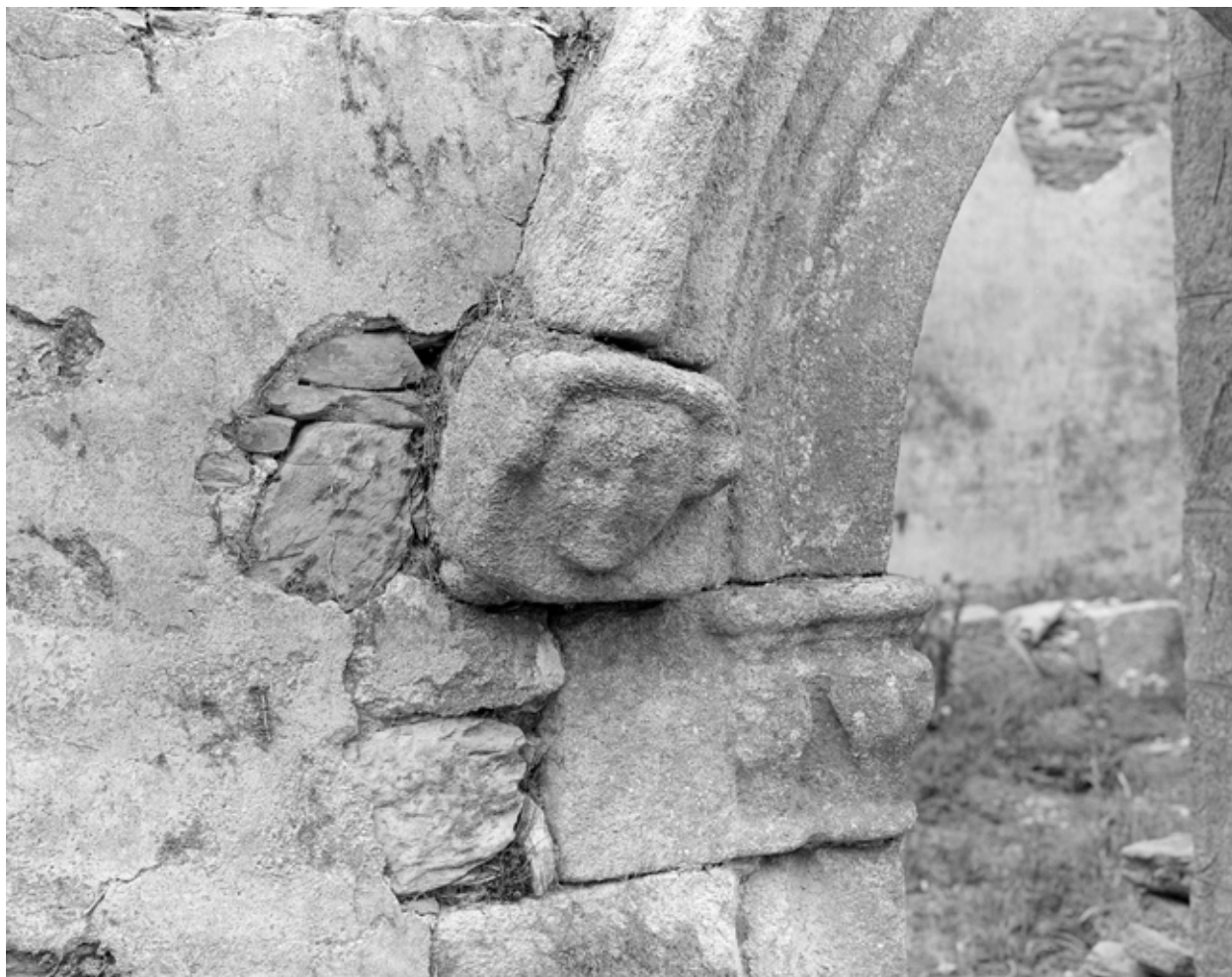
Nef, élévation sud, détail de la porte : retombées de l'arc et de l'archivolte du piédroit gauche
