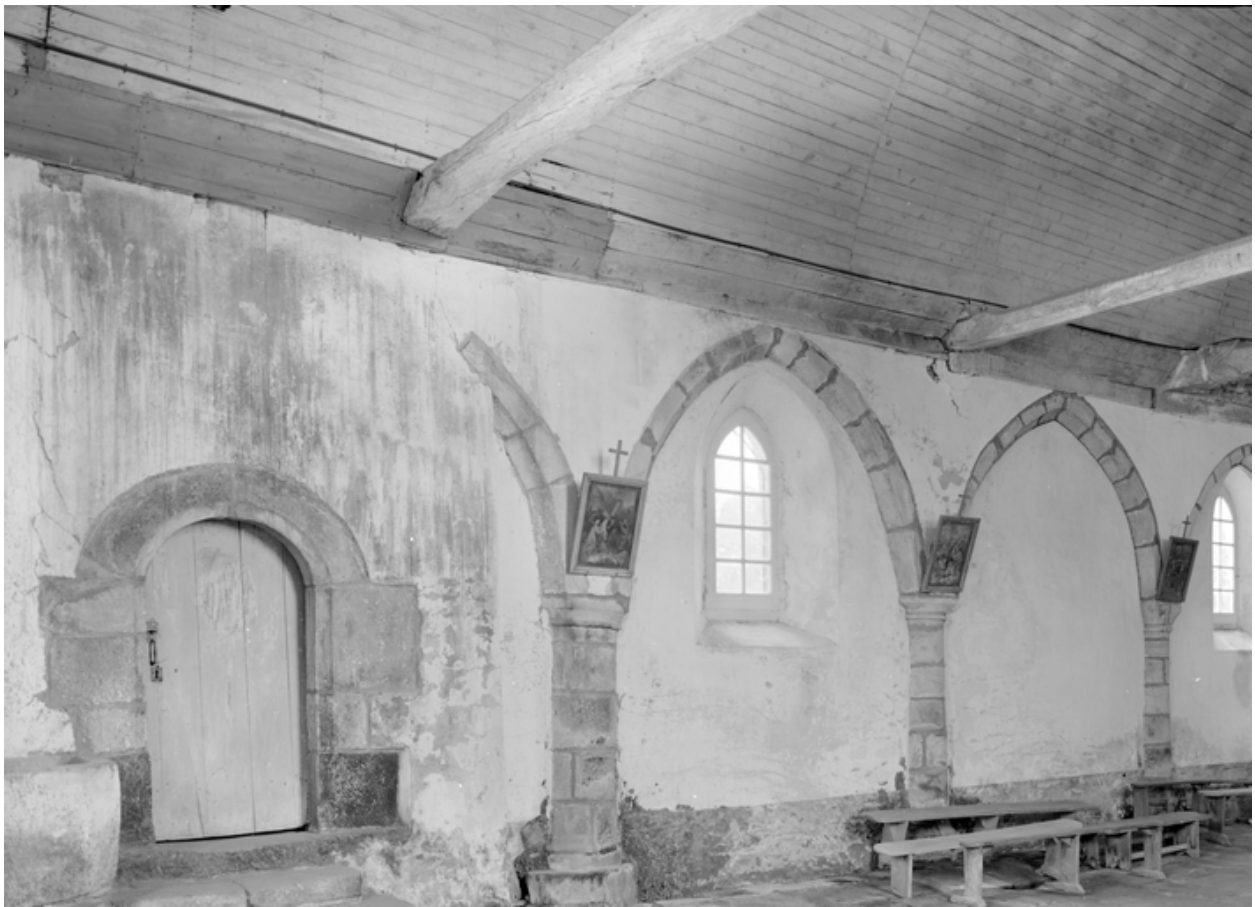
Chapelle Saint-Golven : mur nord de la nef (état en 1984)
