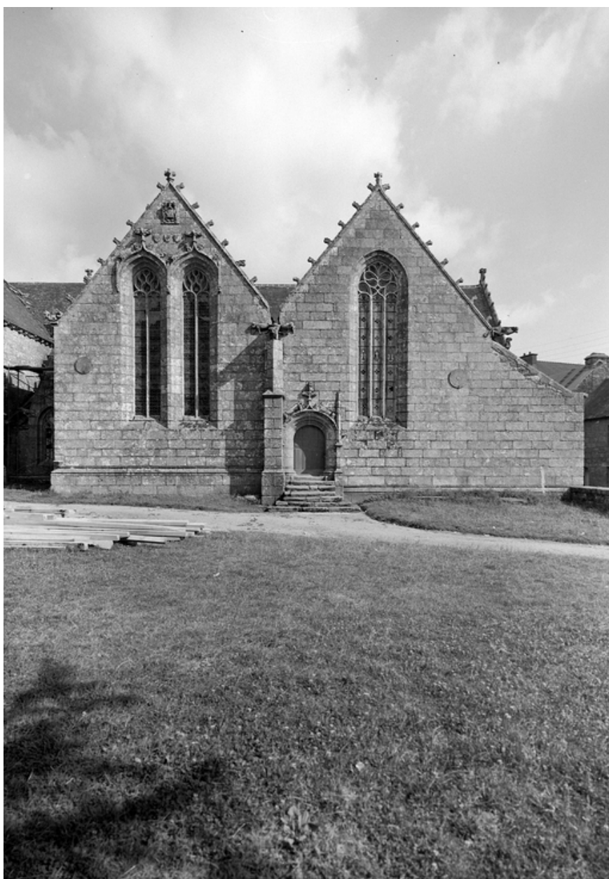
Croisillons sud : élévation sud
