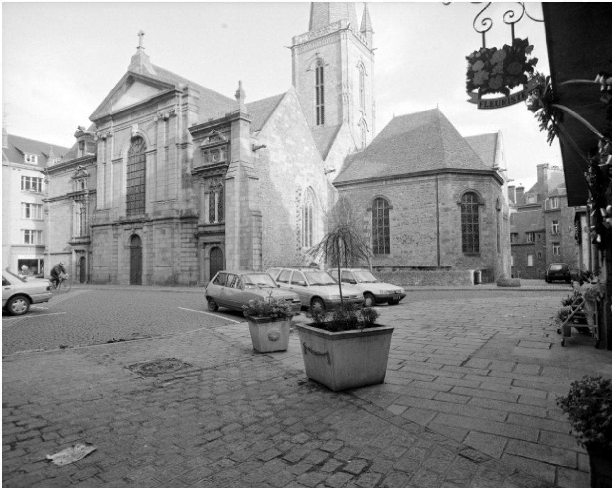
Elévation Sud-Ouest : vue générale
