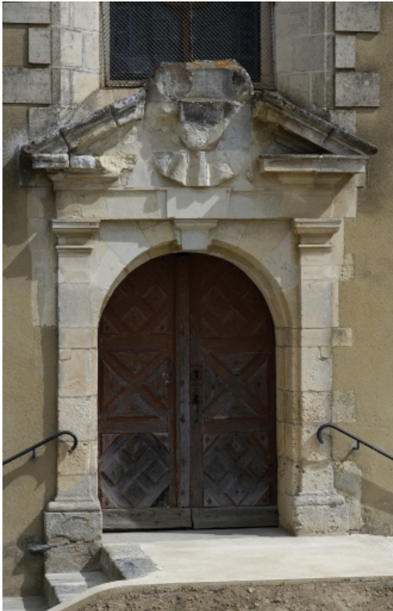
Porte sud de l'église paroissiale
