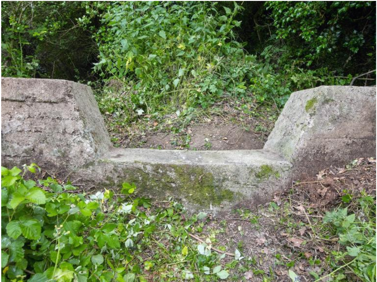
Vue du parapet du mur de clôture et de soutènement ceinturant le domaine : emplacement de tir situé à l'extrémité Est de la pointe près du bunker - casemate VF
