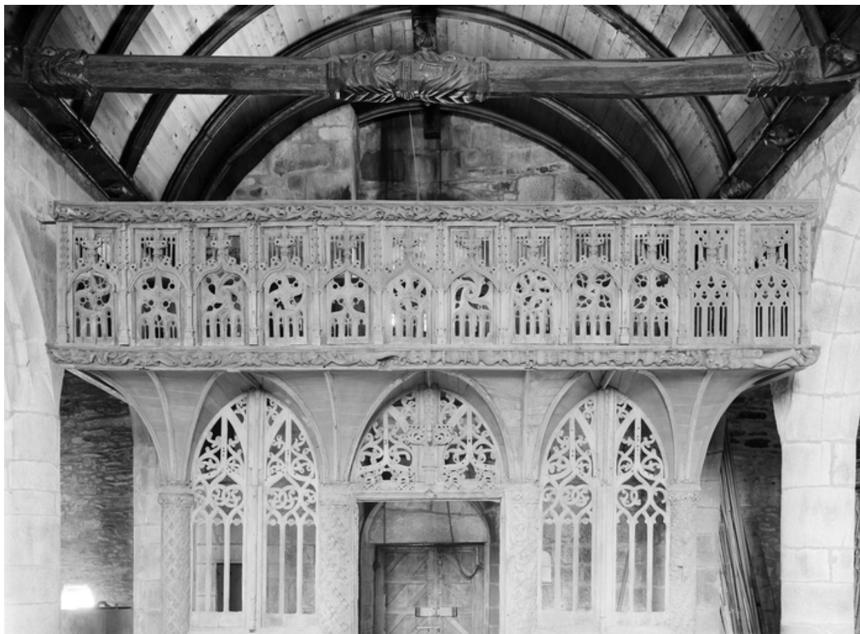
Jubé, face est : vue d'ensemble de la partie supérieure axiale
