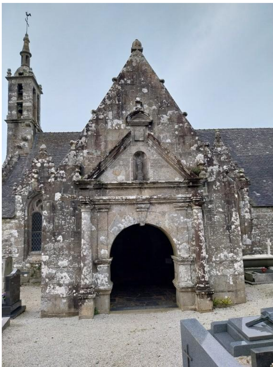
Porche sud, vue de face
