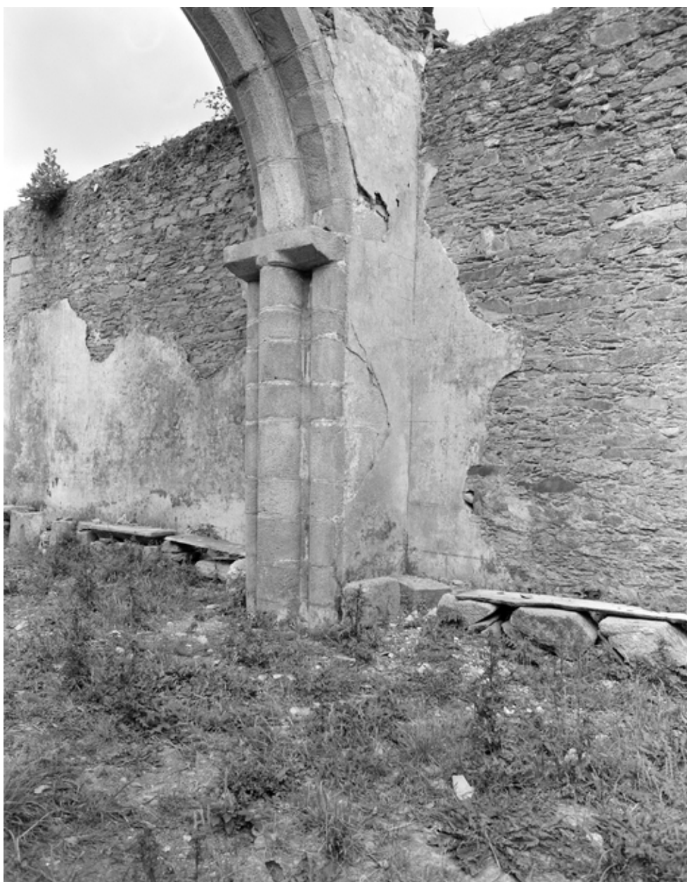
Arc diaphrame de la nef, pilier nord pris de l'est
