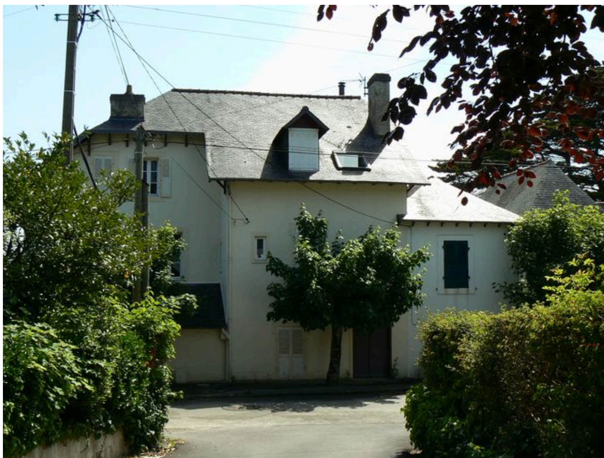
Vue de l'arrière de la villa Coquette
