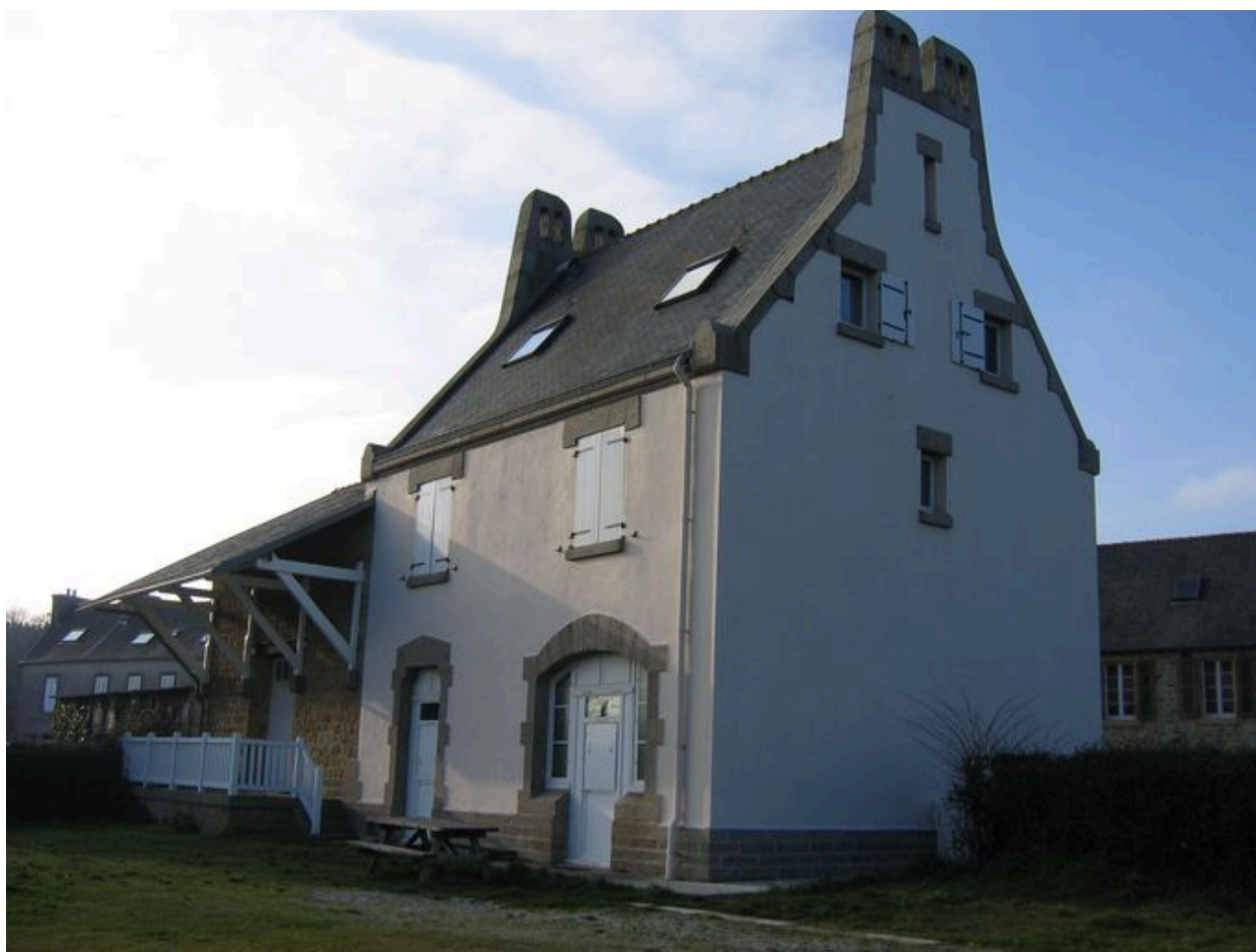
Vue générale de la gare du Fret
