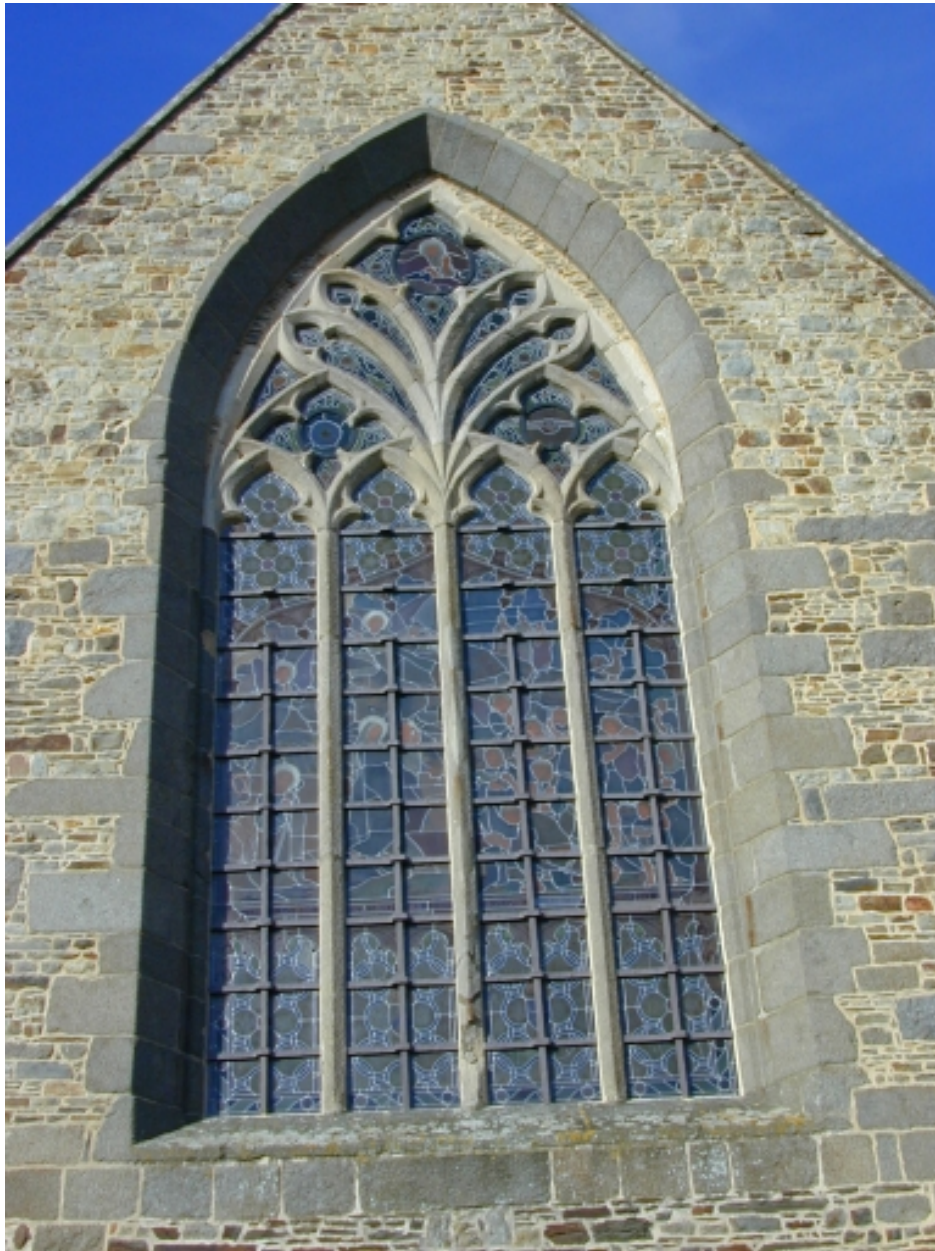
Chevet, la verrière : vue générale est
