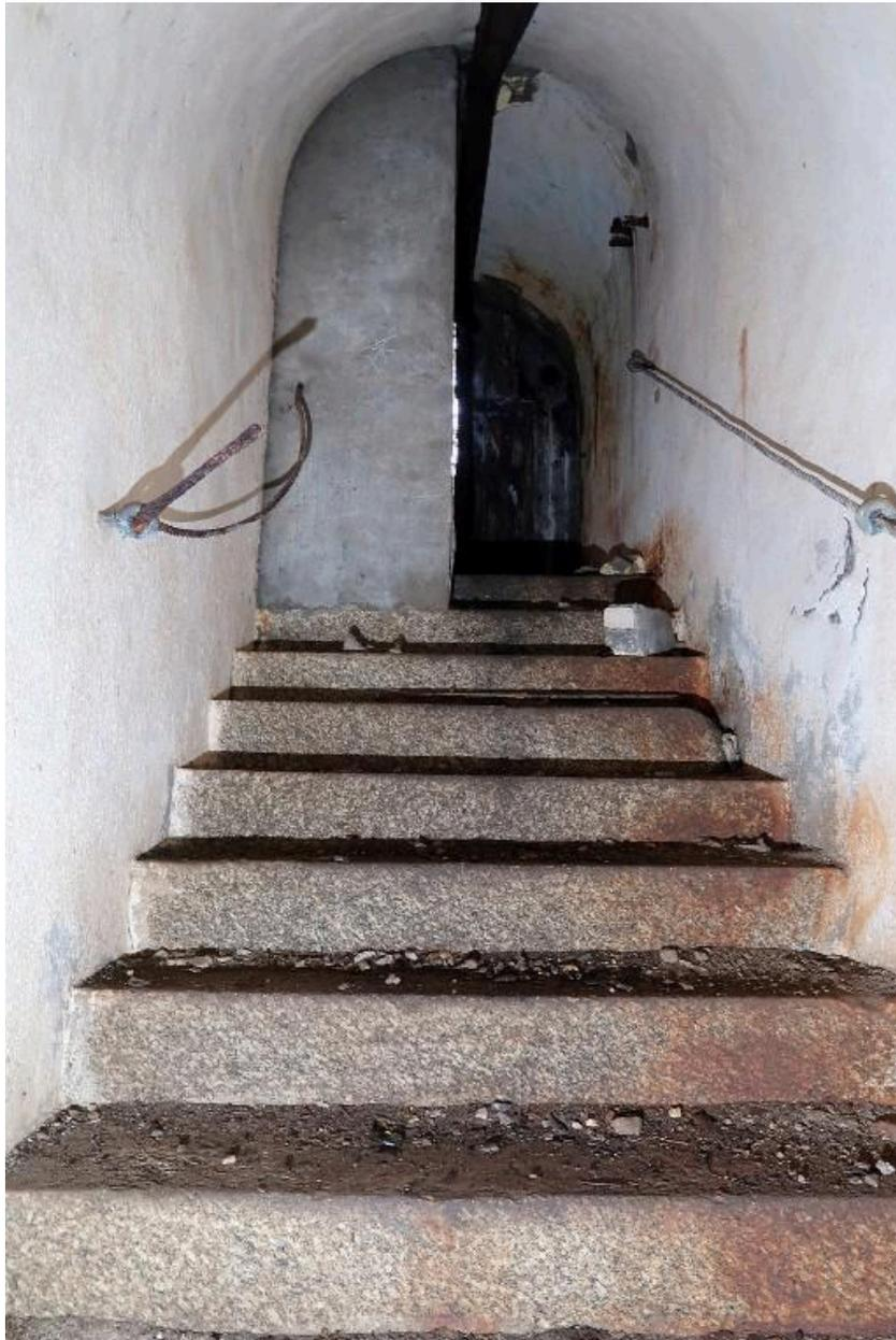
Vue de l'escalier d'accès avec ses marches en granite. Suspendu au plafond, le rail permettait la manutention des obus via le treuil manuel à tambour
