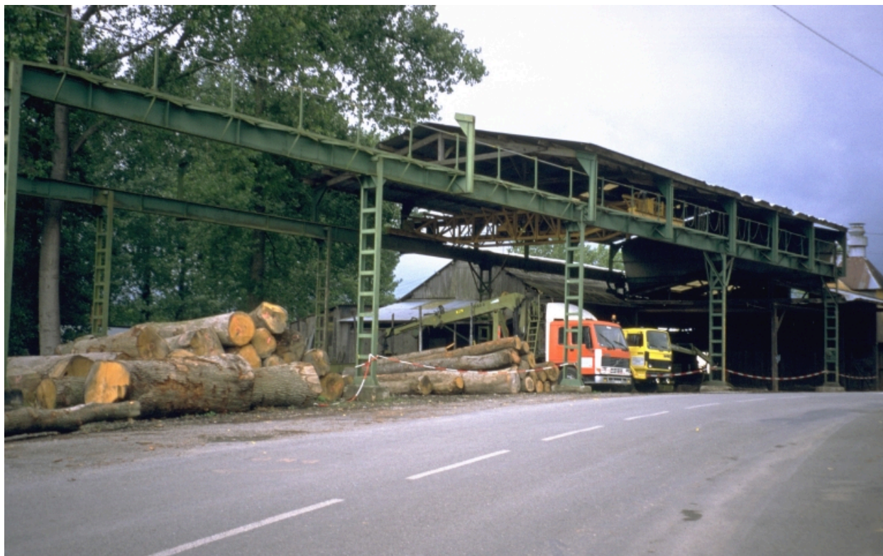
Vue générale nord-est : atelier et pont roulant.
