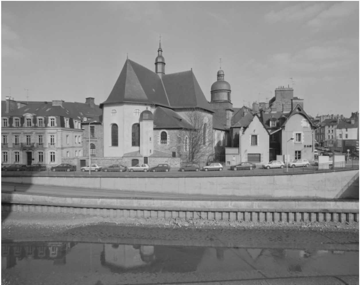
Elévation Ouest : vue de situation
