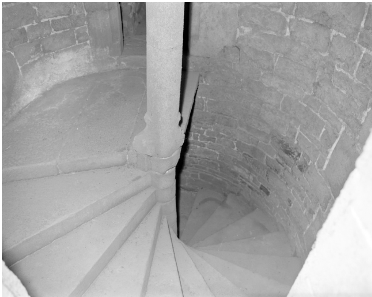
Plafond de l'arrivée de l'escalier
