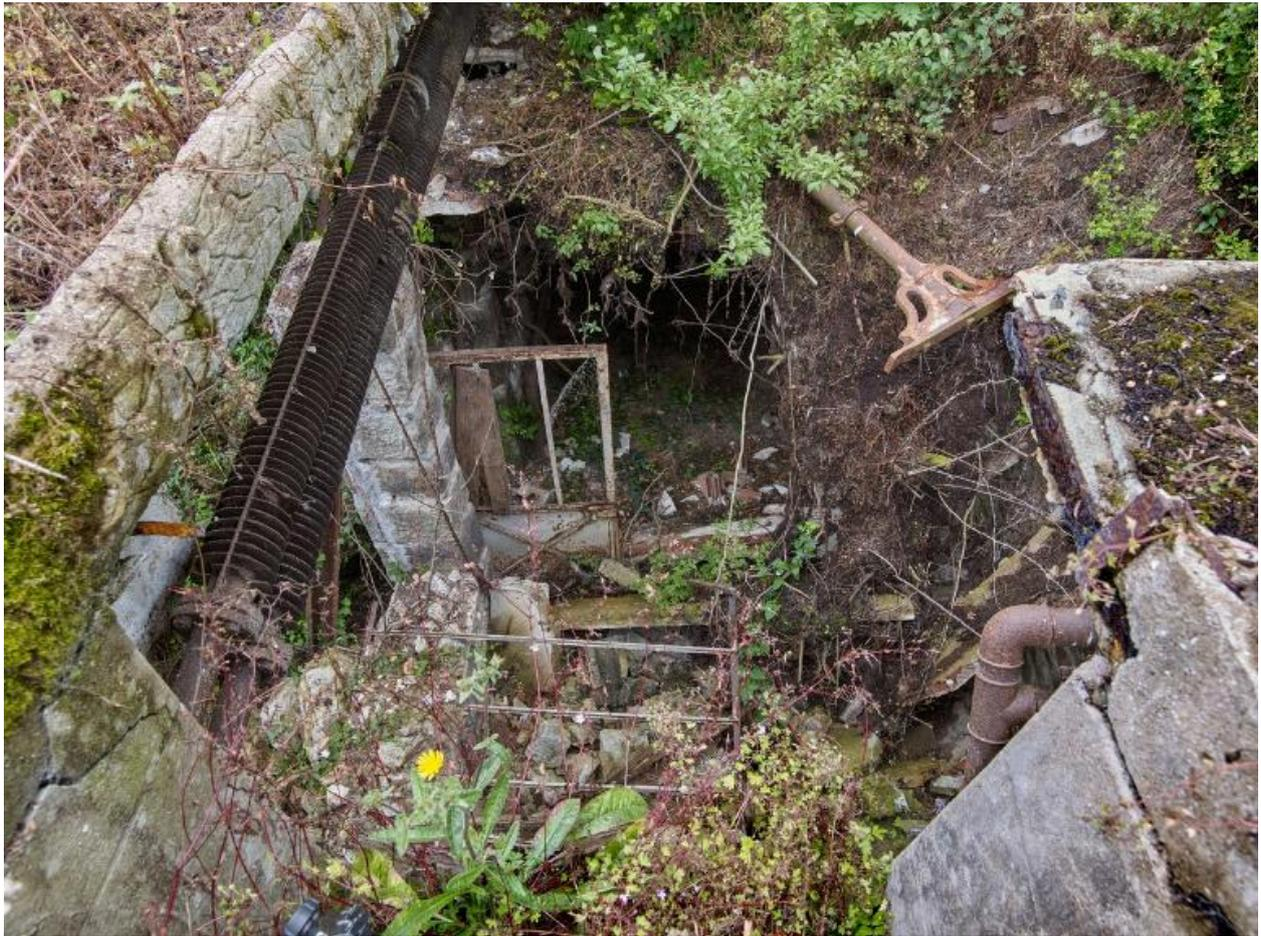
Vue de la serre située au Sud : sous-sol (le plancher du rez-de-chaussée s'est effondré), local technique à usage de chaufferie ; vestiges de portes vitrées. A gauche, radiateur horizontale de serre ; à droite tuyaux et poteau ouvragé
