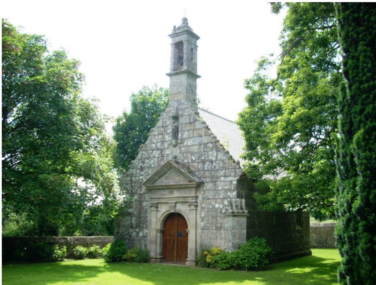
Lannilis, chapelle Saint-Sébastien : vue générale sud-ouest
