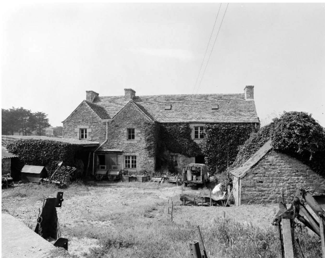
Kersuguen, Ferme : vue générale sud
