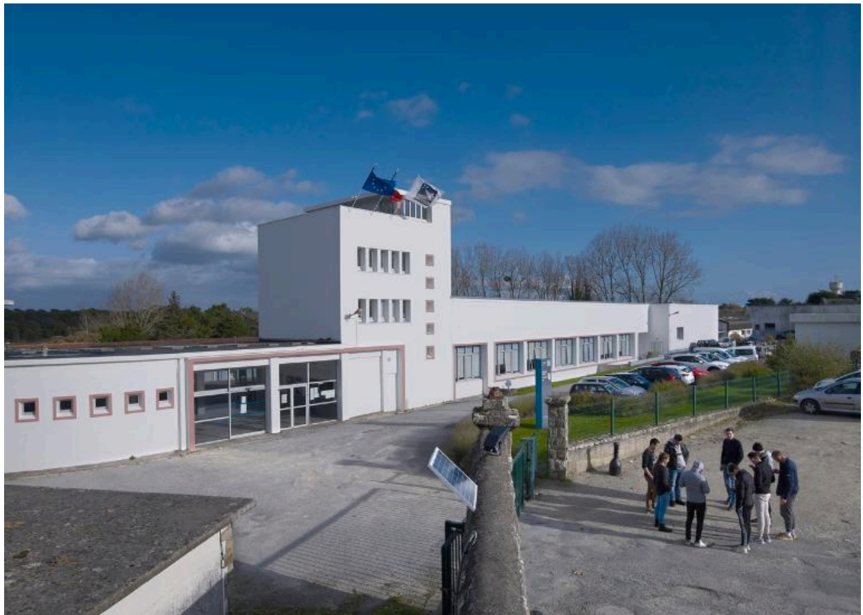
Vue d'ensemble administration et externat, à l'arrière plan les ateliers (bâtiments A1 et A2), vue prise du sud-ouest.
