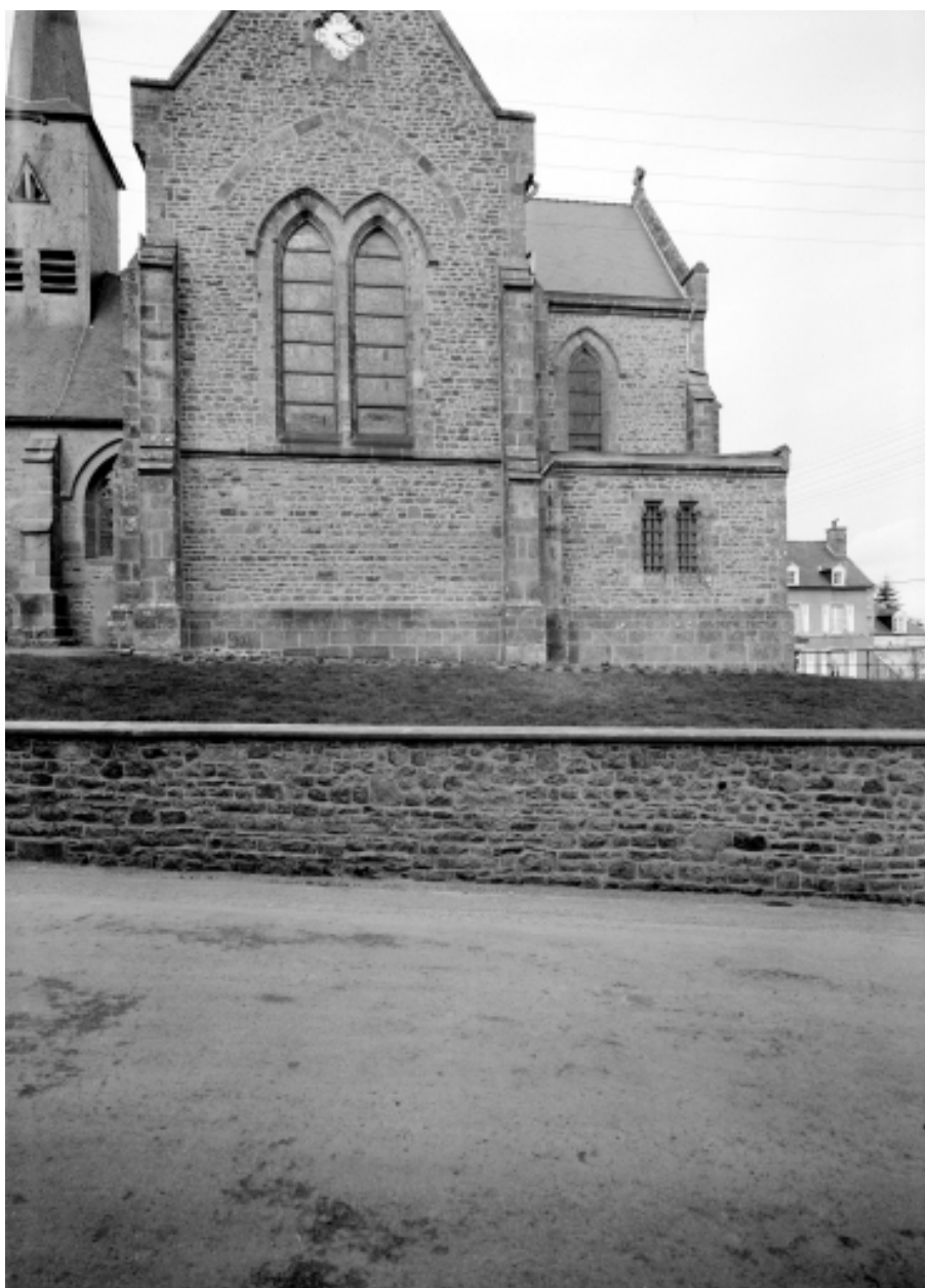
Elévation Est : vue générale
