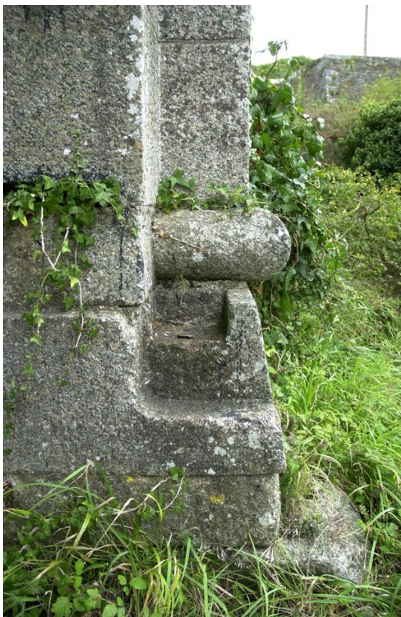
Vue de détail de la porte monumentale datée de 1878 : support en granite du pont-levis basculant (état en 2007)
