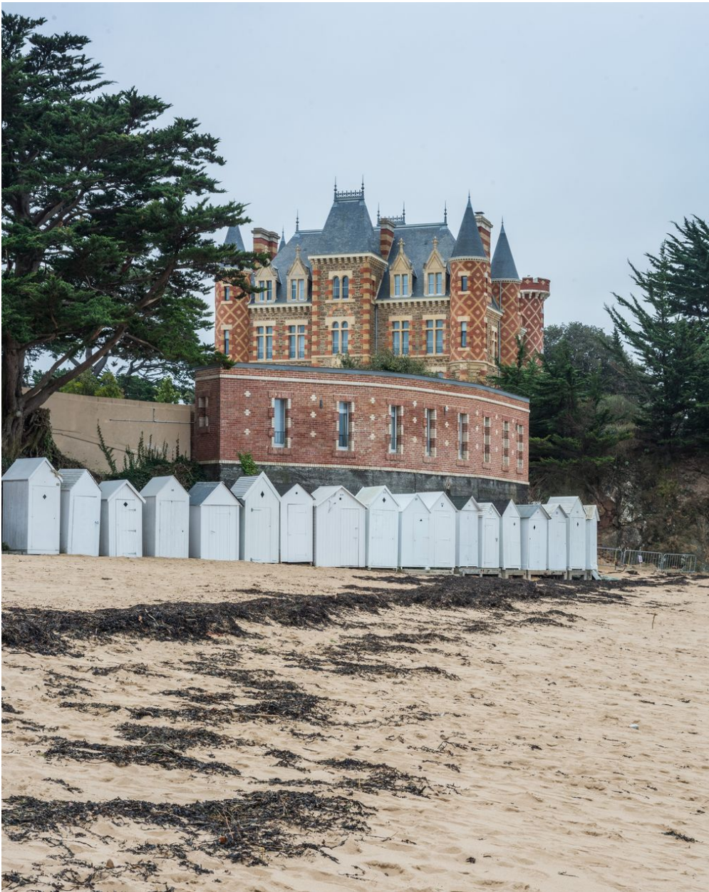
Vue de situation à l'ouest
