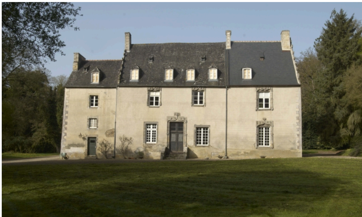
Logis, vue générale
