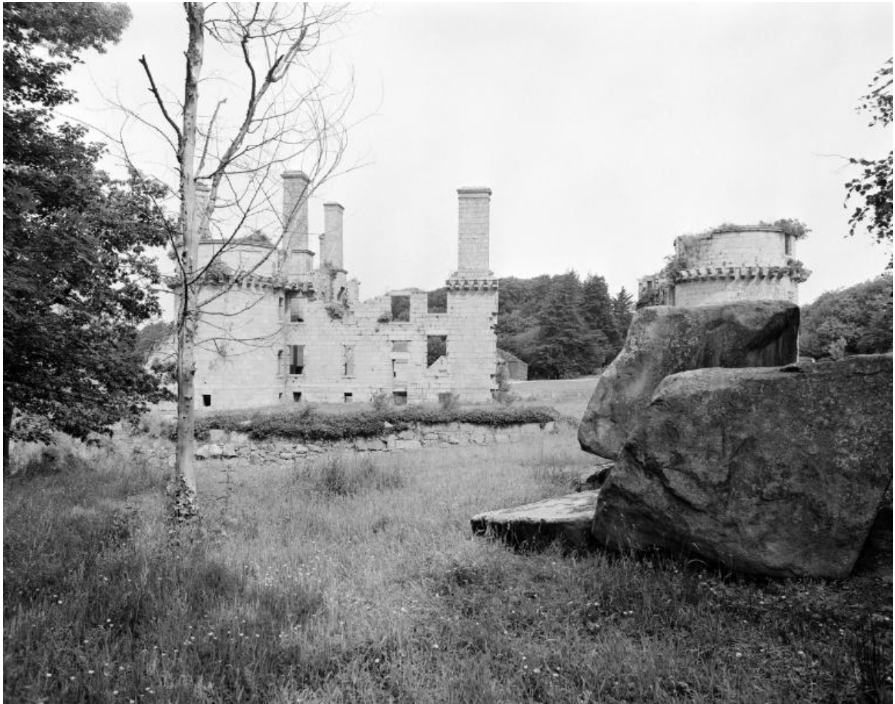
Vue générale depuis l'est (état en 1986). La courtine sud-est a été partiellement détruite
