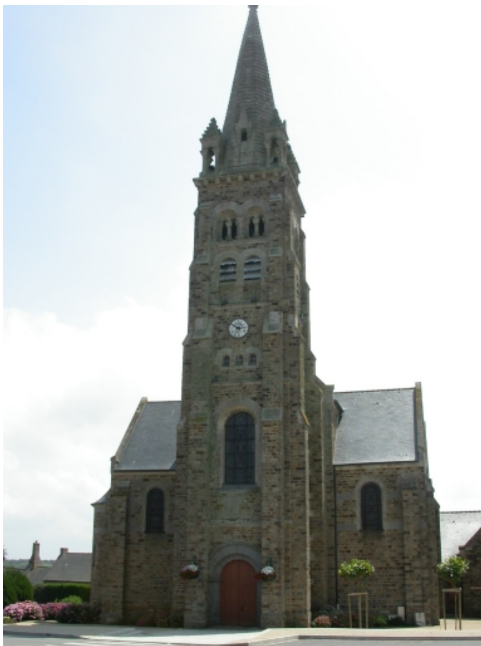
Vue générale de l'élévation nord
