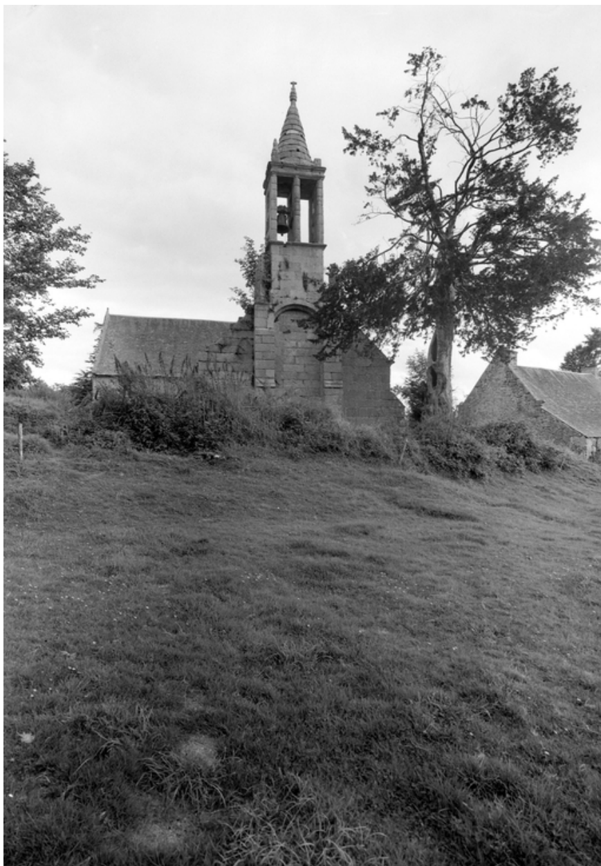
Vue générale de la face ouest
