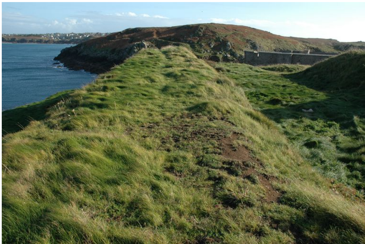
Vue du parapet de la batterie haute
