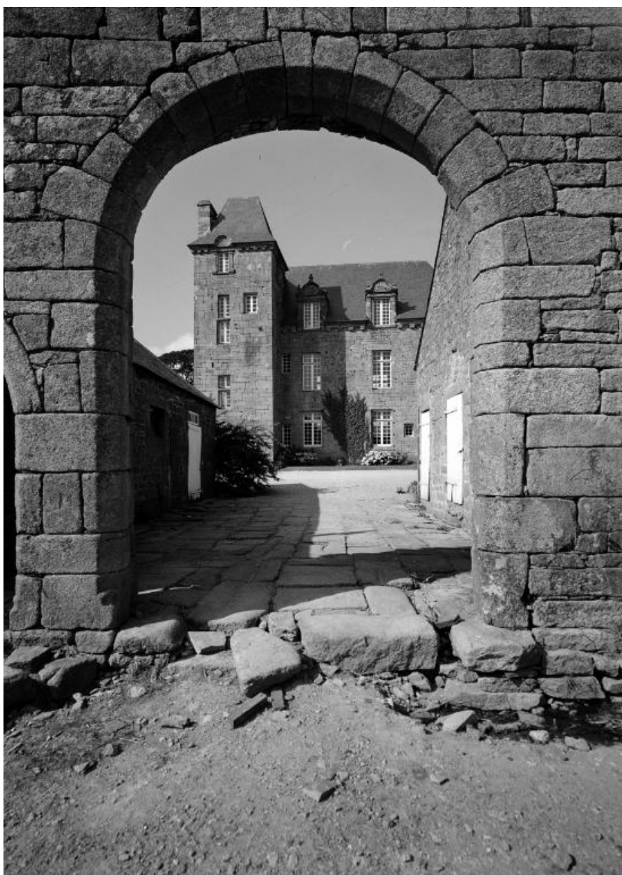
Vue d'ensemble de la façade sud, prise de la porte sud
