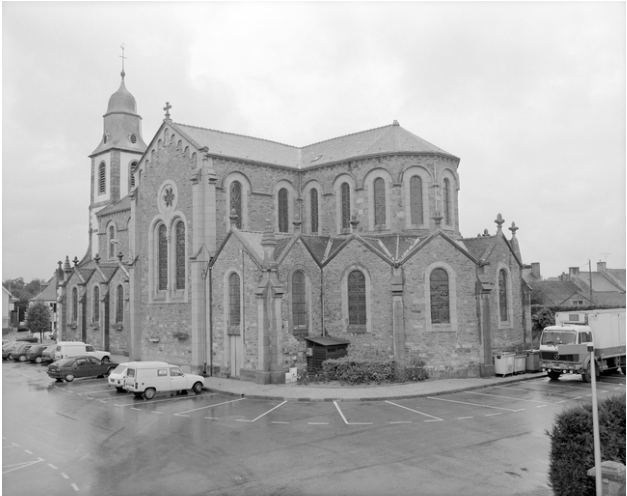
Elévation Est : vue générale
