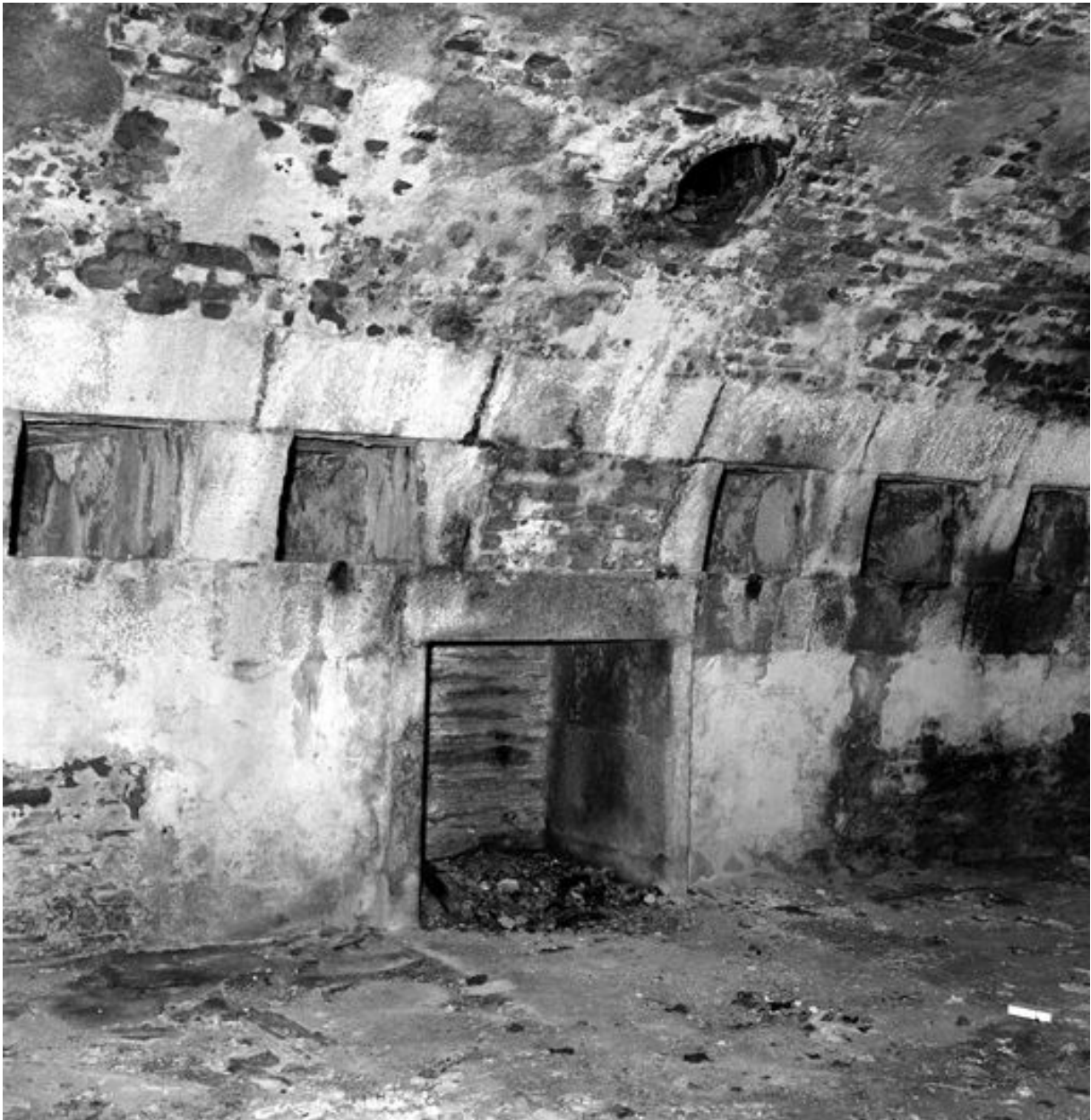
Vue de la tour-modèle n° 1 type 1811 de la pointe de Cornouaille en 1969 : deuxième niveau percé de créneaux de fusillade, cheminée
