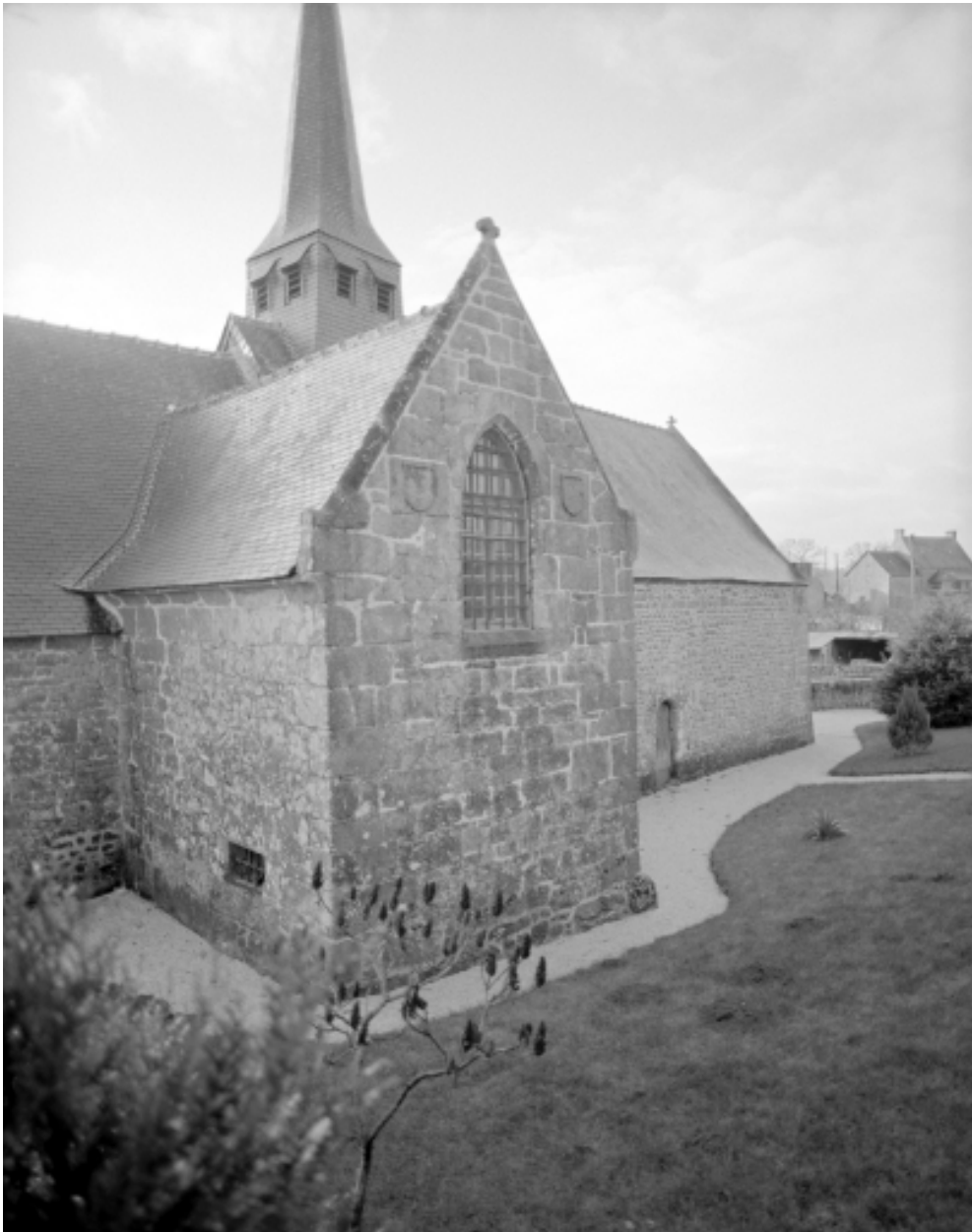
Elévation Nord-Est : vue générale
