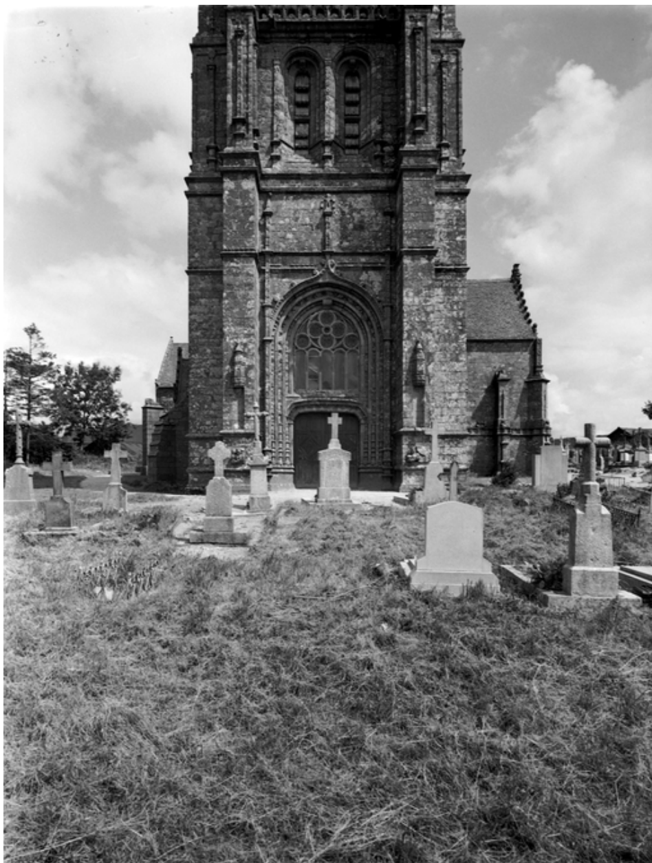
Tour ouest : vue générale
