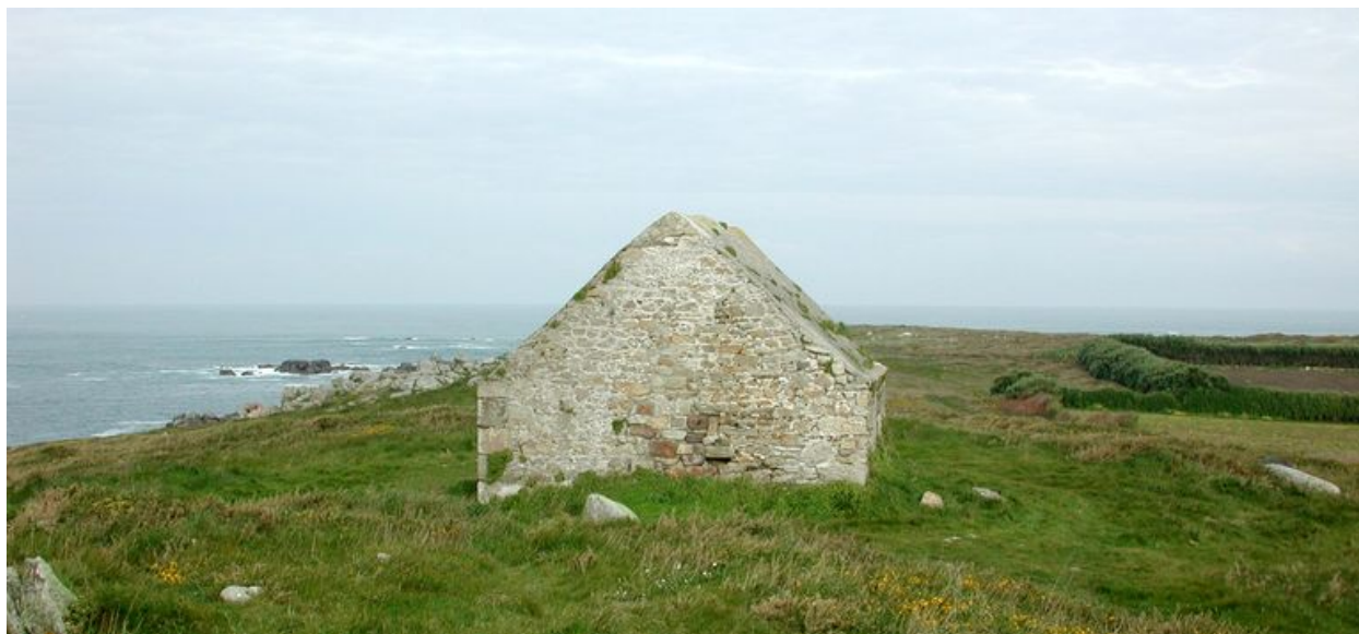
Vue du pignon Sud (état en 2002)
