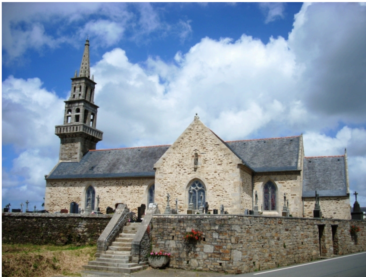
Lanarvily, église paroissiale : vue générale sud-est
