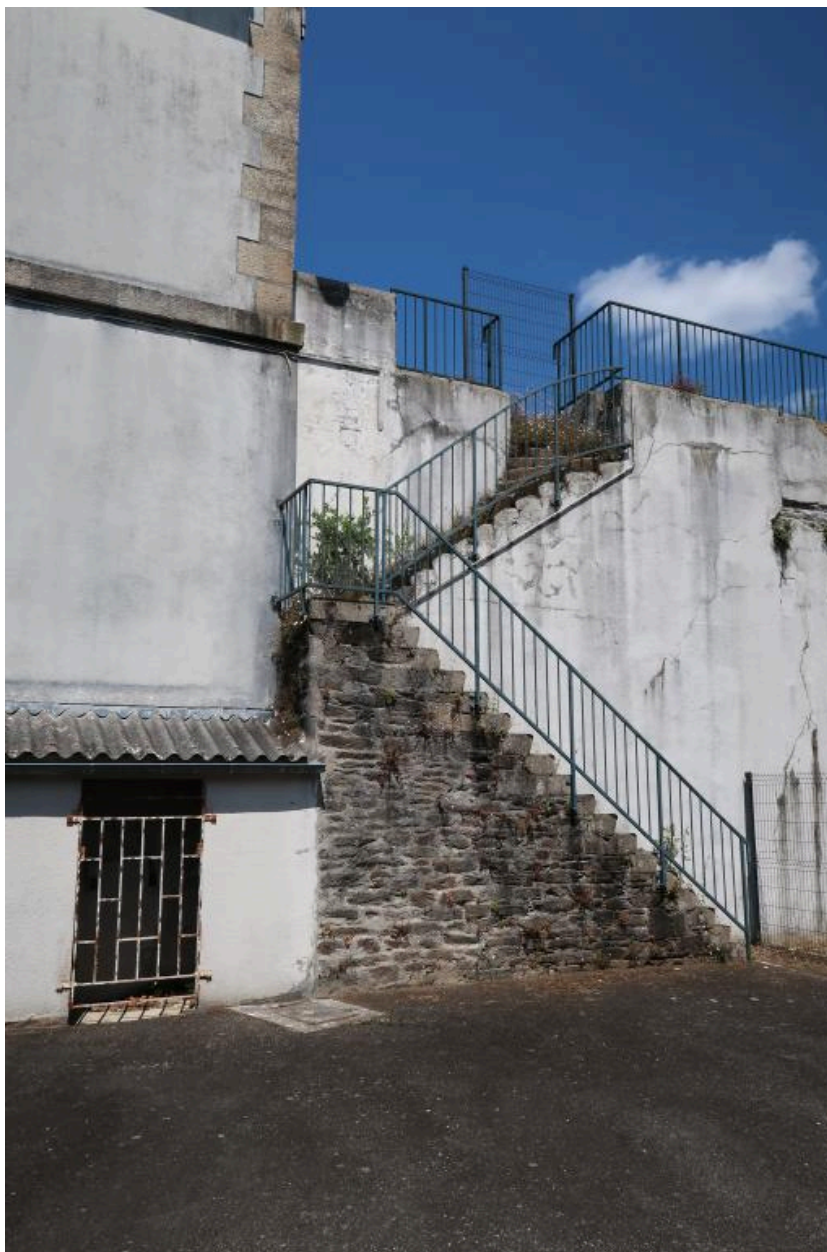
Vue de l'extrémité est : escalier (état en 2022)
