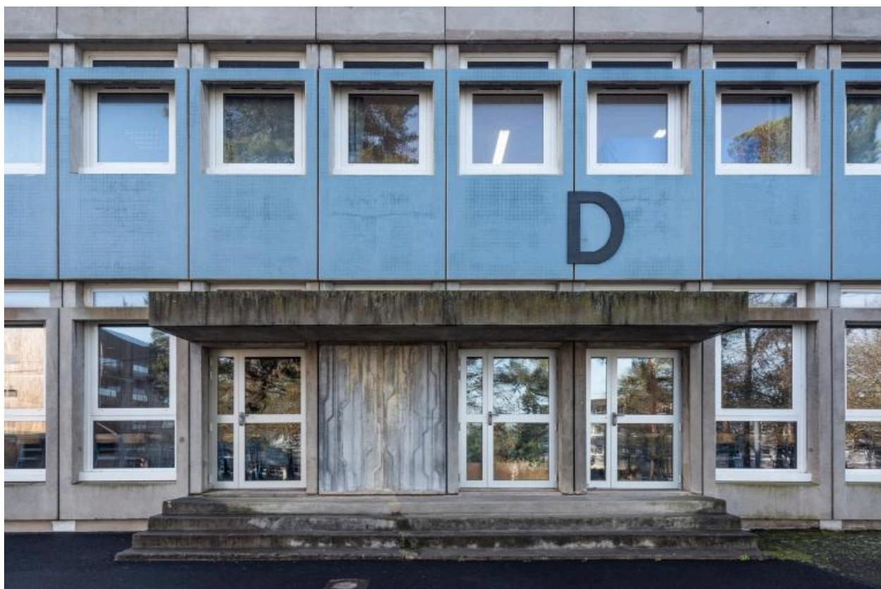
Détail de la façade du bâtiment D (service de restauration et ancien infirmerie). La capucine, est un élément distinctif des bâtiments qui abritent les services commun, la modénature s'enrichit d'un panneau de béton brut avec moulures en relief. comme pour l'ensemble des bâtiments, les panneaux de béton préfabriqués sont recouverts de petits carreaux de grès, et traités de façon à souligner l'imposte des fenêtres, une façon de casser la verticalité de la trame de 1,75m.
