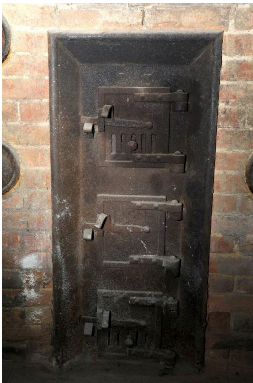
Porte de la cave à charbon
