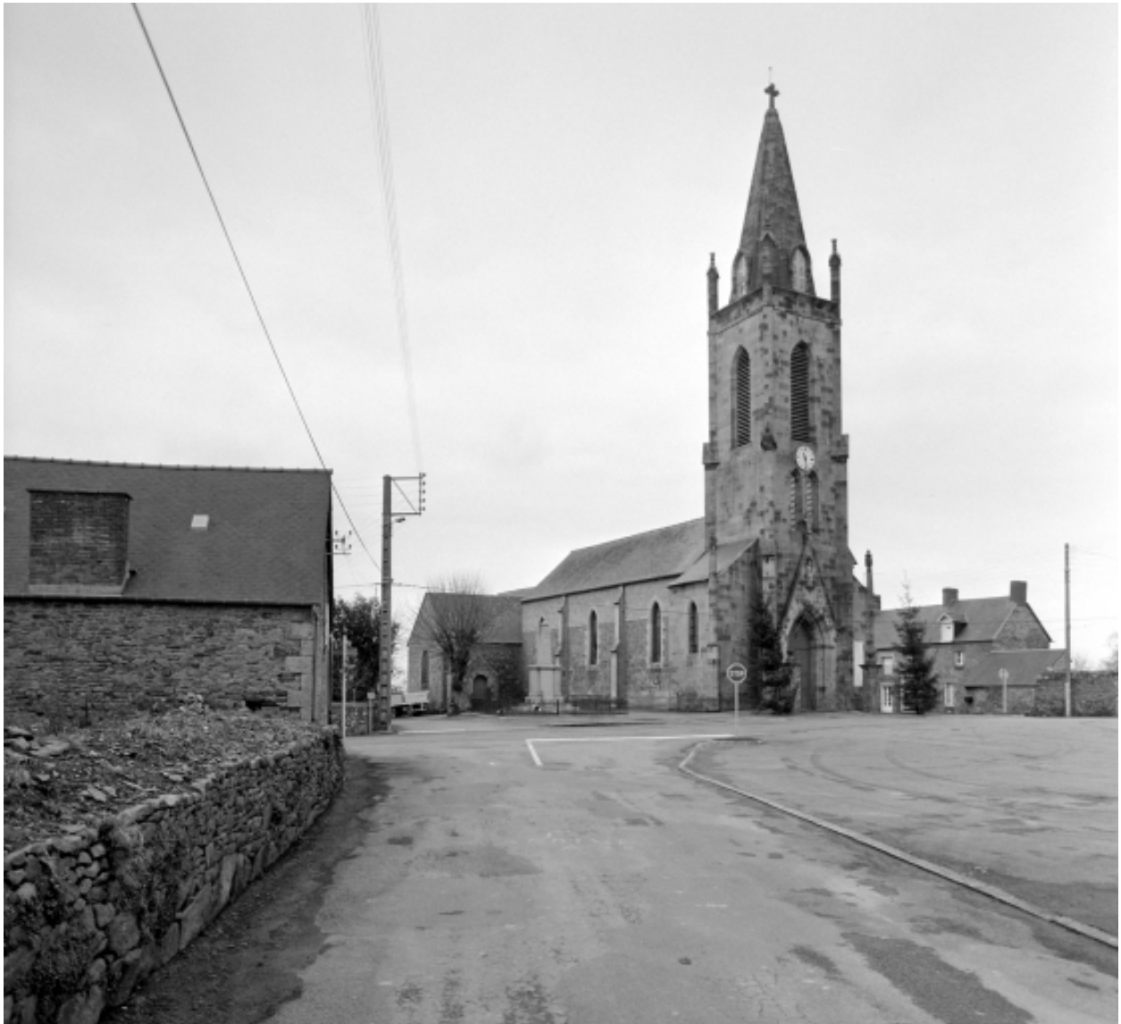
Elévation nord-ouest : vue générale
