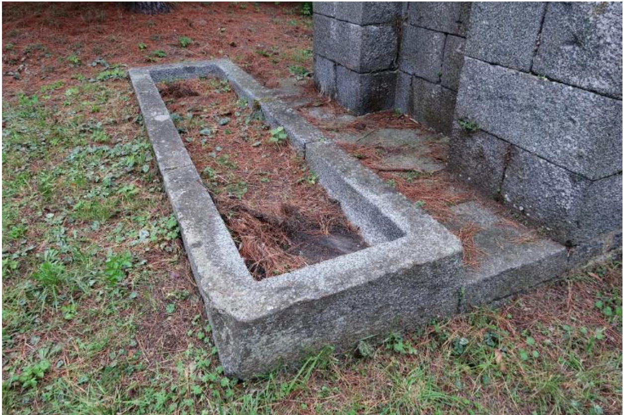
Vue de la table en granite permettant le stockage des boulets froids en attendant leur enfournement (état en 2024)
