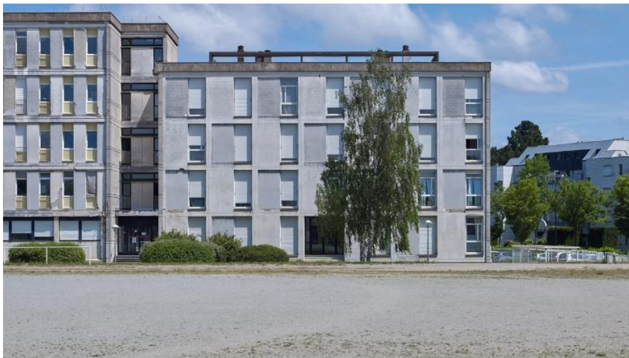
Façade ouest de l'internat de garçons : aile sud abritant les logements. Noter la cage d'escalier vitrée à l'articulation avec les chambres des élèves. Louis Arretche et Jean Lemerrier, architectes, 1967
