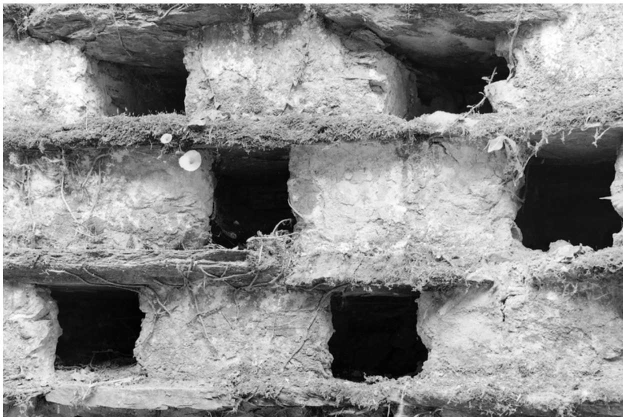
Pigeonnier, vue de détail de l'intérieur.
